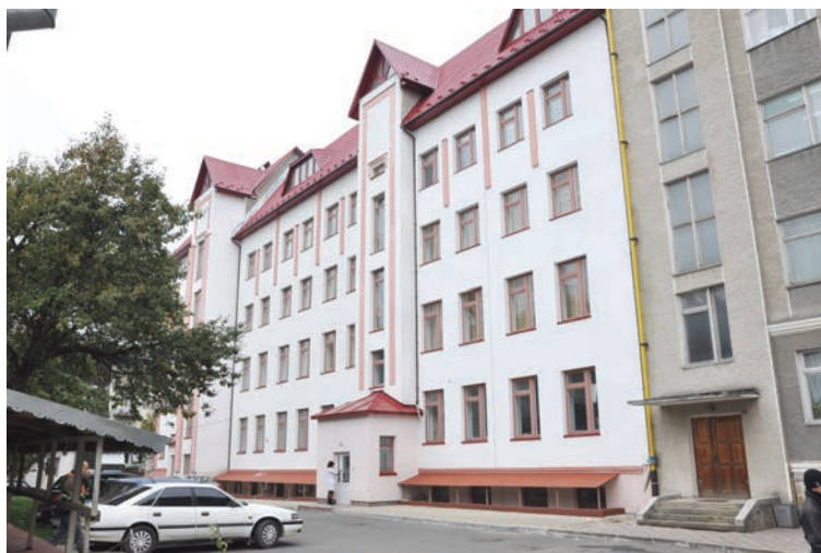
Новозбудований хірургічний корпус, м.Тернопіль, 2009 рік
