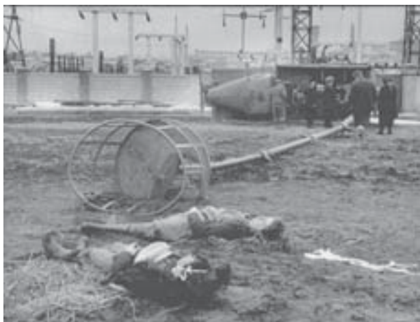
Рис. 419. Місце пригоди: три робітники ублагали шофера покатати їх на телескопічній вишці, встановленій на автомашині ЗІЛ-157-К. Внаслідок порушення правил техніки безпеки кошіль вишки з робітниками, який був піднятий на висоту 25 метрів, упав разом із автомашиною. Двоє чоловіків від отриманих ушкоджень померли на місці, а третього, котрий вискочив з падаючого кошеля, з переломами стегнових кісток відправлено в лікарню.
